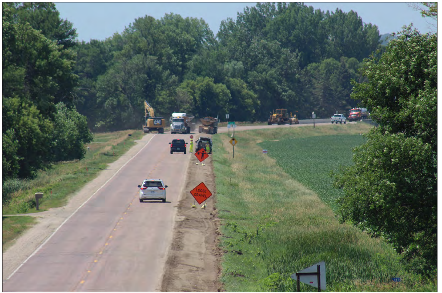
Mavis Fodness photo/0721 Work on CSAH 4
